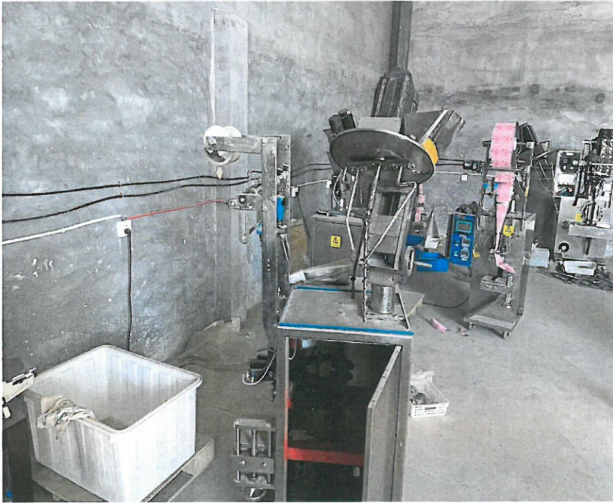
图 1.4、现场勘查照片（四）
